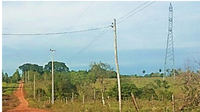
Ejecución de Trabajos de Normalización de Líneas de Autoayuda de BT y MT Licitación Pública Nacional ANDE N° 991/2014 - Lotes 3 y 6 - BONOS I
